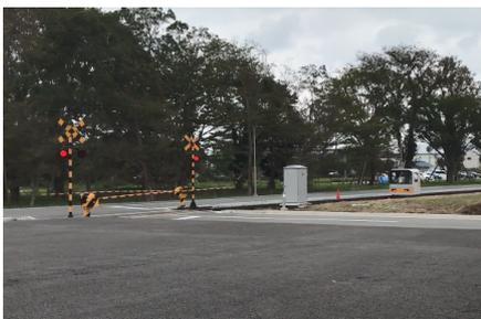
鉄道車両の位置情報を、携帯電話回線を用いてセンターサーバーに送信し、踏切警報機・遮断機を制御するシステムが株式会社京三製作所より提案されています。そのシステムを拡張すれば、自動車、交通信号機への信号の送信も可能になり、交通信号機および、自動運転・運転支援車両を含めた、多モードの交通車両の制御が可能になります。柏キャンパスでの鉄道試験線と ITS 実験フィールドを用いた実験により、実現可能性を検討しています。
